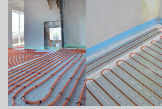
Kombinace s klasickým podlahovým vytápěním
