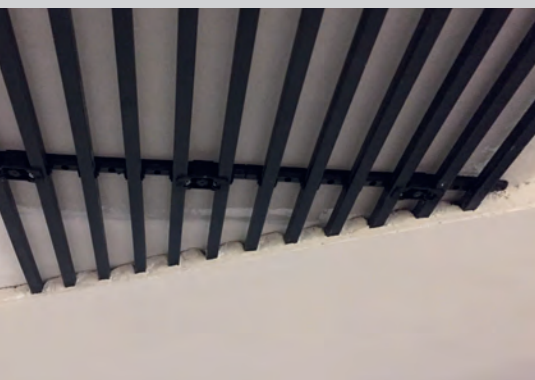
Stropní vytápění a chlazení – omítka
